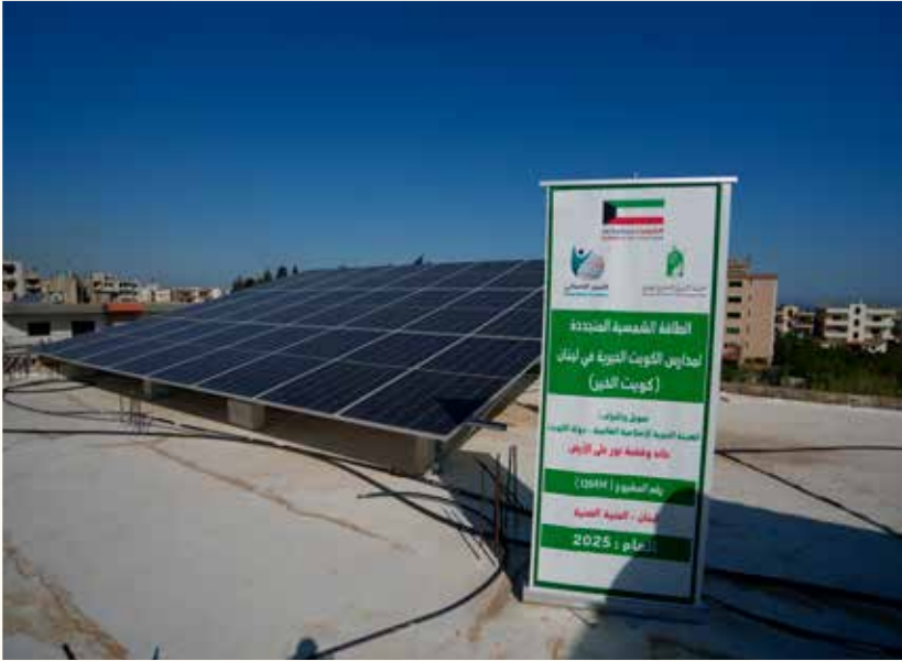
■ الألواح الشمسية لمواجهة أزمة انقطاع الكهرباء
