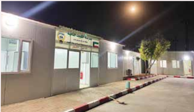
■ مدرسة الكويت الثانية بعد بنائها وإعادة ترميمها
