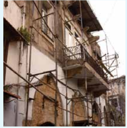
■ من أعمال إعادة الترميم ومتابعة من أطفال الحي
