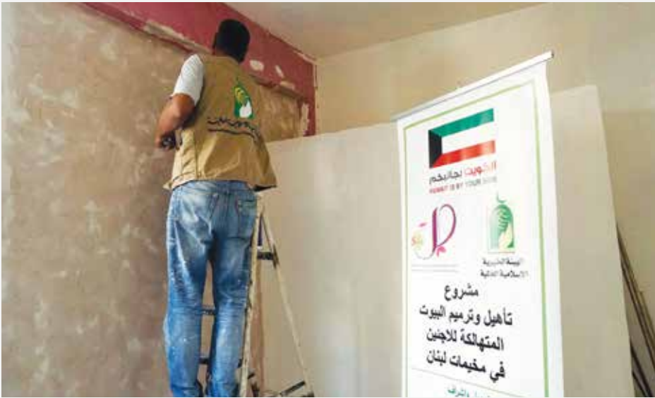
■ جانب من مشروع ترميم المنازل المتصدعة
