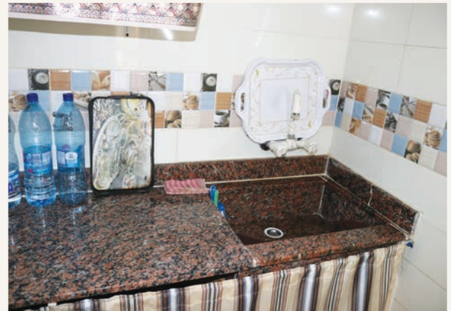
■ جانب من أعمال الترميم
